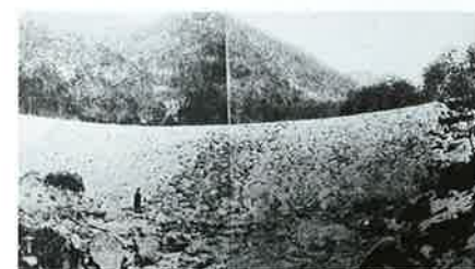
総社市見延地内 明治33年度施工石積堰堤
