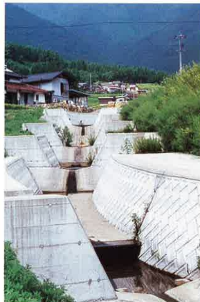
■吉井川水系 譲葉川(英田郡東栗倉村) 河床勾配を緩やかにし、下流への土砂流出を軽減する床固工、流路工
