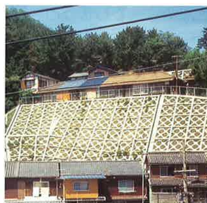
■釜屋床地区（玉野市） 斜面の崩壊を防ぎ人家を守る法枠工
