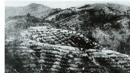
総社市横谷地内 明治38年施行の状況
